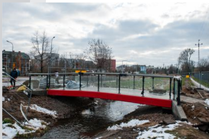
Fot. Nowy mostek na Piłsudskiego/Żwirki
