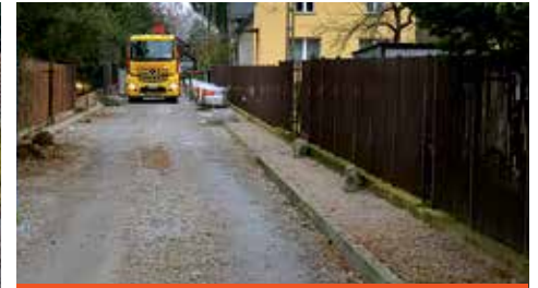
♦ ul. Ślusarska (w budowie)
