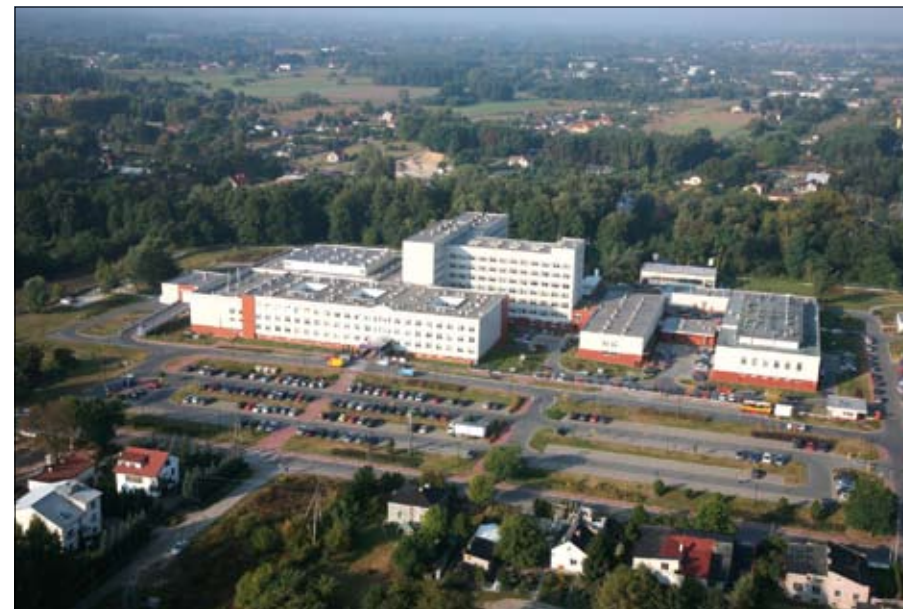
Specjalistyczny Szpital Zachodni im. Jana Pawła II w Grodzisku Mazowieckim. W 1996 r. - po 4 latach przerwy - wznowiono budowę szpitala i ostatecznie w 2002 r. uruchomiono pierwsze obiekty szpitalne.
