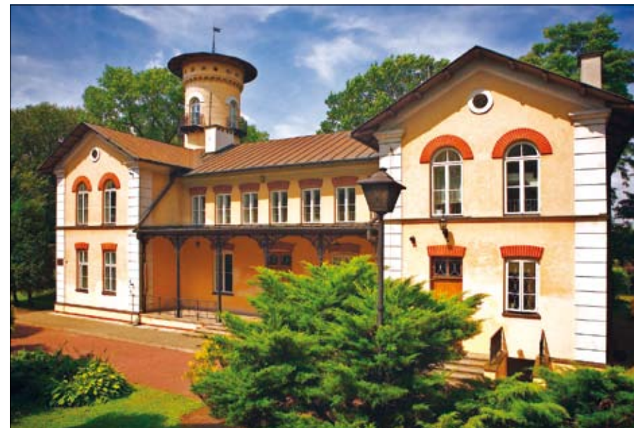
Willa „Foksal” przy ul. Bartniaka, obecnie mieszczą się w niej biura Krajowego Ośrodka Badań i Dokumentacji Zabytków.
