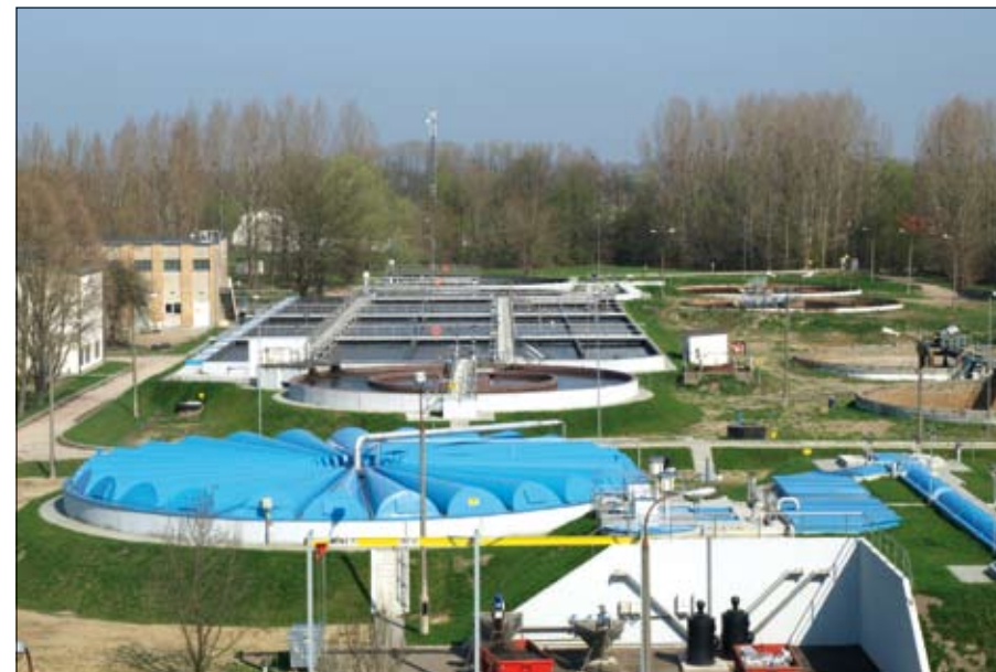
Zmodernizowana Oczyszczalnia Ścieków w Grodzisku Mazowieckim, oddana do użytku w grudniu 2009 r. Modernized Sewage Treatment Plant in Grodzisk Mazowiecki opened in December 2009.
