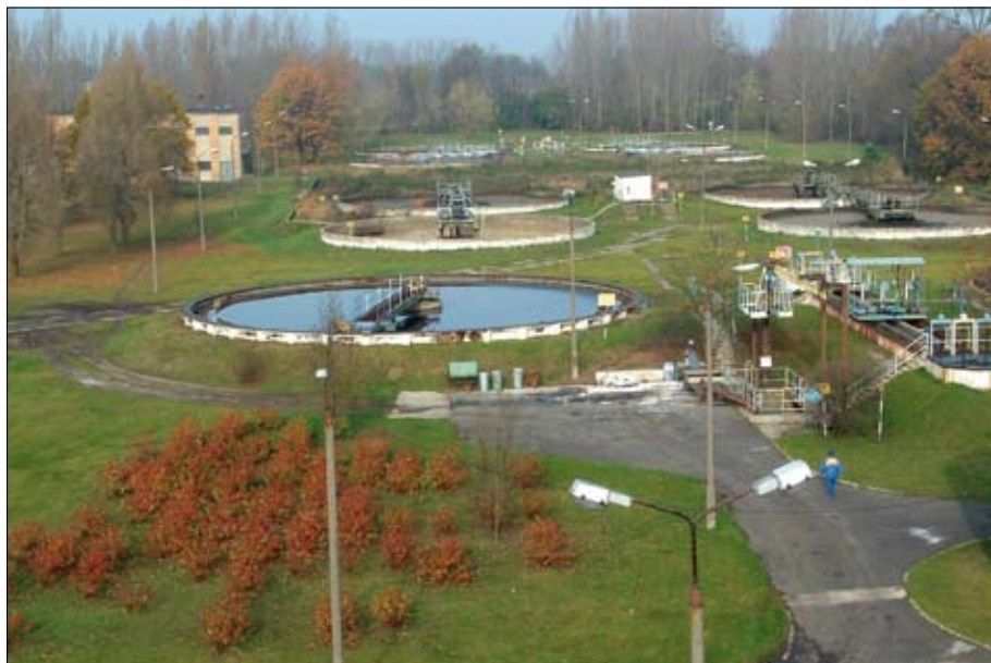
W 1989 roku została oddana do eksploatacji pierwsza grupowa oczyszczalnia ścieków. In 1989 the first Group Sewage Treatment Plant was opened.
