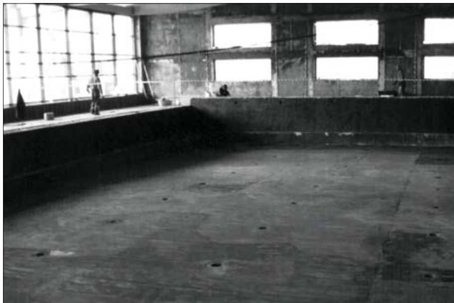
Budowa basenu przy ul. Montwiłła w Grodzisku Mazowieckim. Construction of the swimming pool at Montwiłła Street in Grodzisk Mazowiecki.
