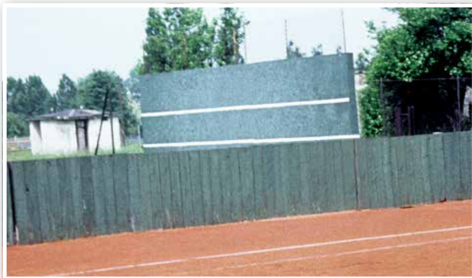
Nowa ścianka betonowa – 1974
