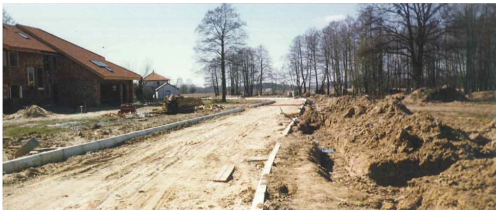
Budowa osiedla Villa Czarny Las I. Fragment jednego z pierwszych domów. To będzie dopiero ulica Sosnowa. W dali widać „przyszłość” czyli jeszcze nieistniejące skrzyżowanie z ulicą Wrzosową (fot. W. Styziński ok. 1996 r.)
