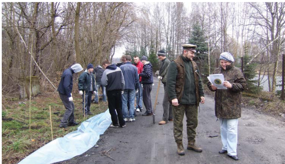
Ustawianie płotków uniemożliwiających żabom wejście na drogę w Makówce (fot. A. Obidziński 2009 r.)
