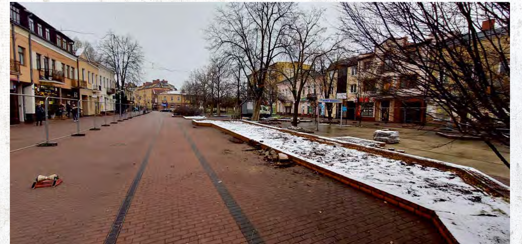
Fot. 1. Grodzisk Mazowiecki, rozpoczęcie prac budowlanych związanych z rewitalizacją Placu Wolności. Widok od strony południowej.
