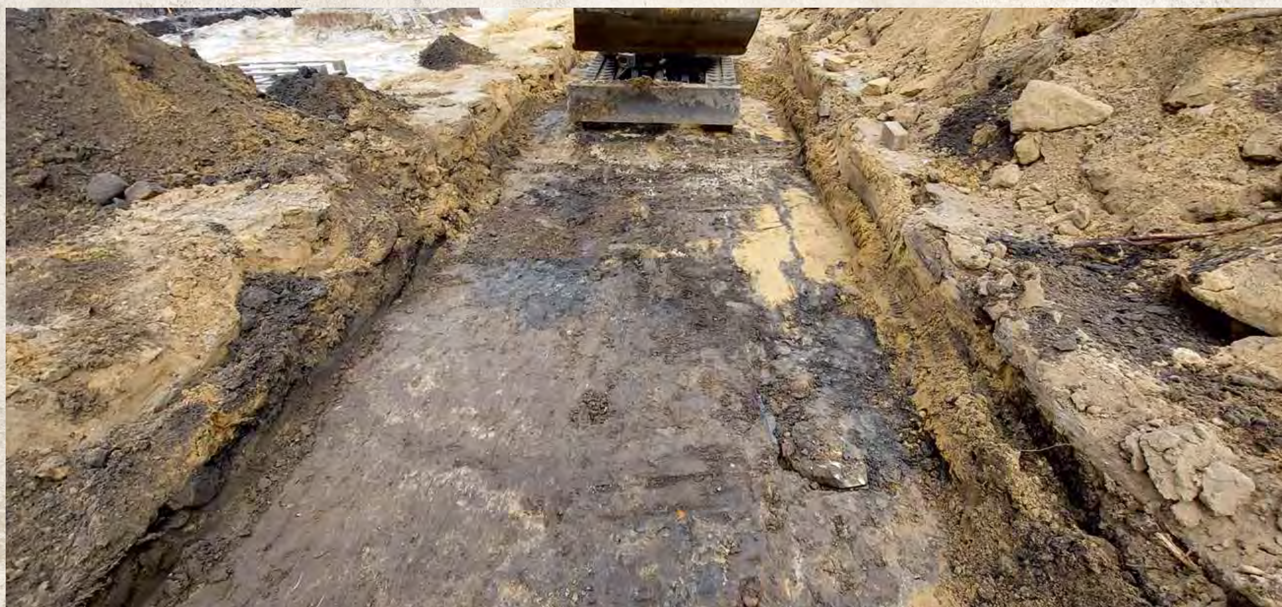
Fot. 1. Grodzisk Mazowiecki, Plac Wolności. Wykop pod kanalizację deszczową. Widoczne ślady zniszczenia po budowie wcześniejszej kanalizacji (lata 60.) Widok od strony południowej.
