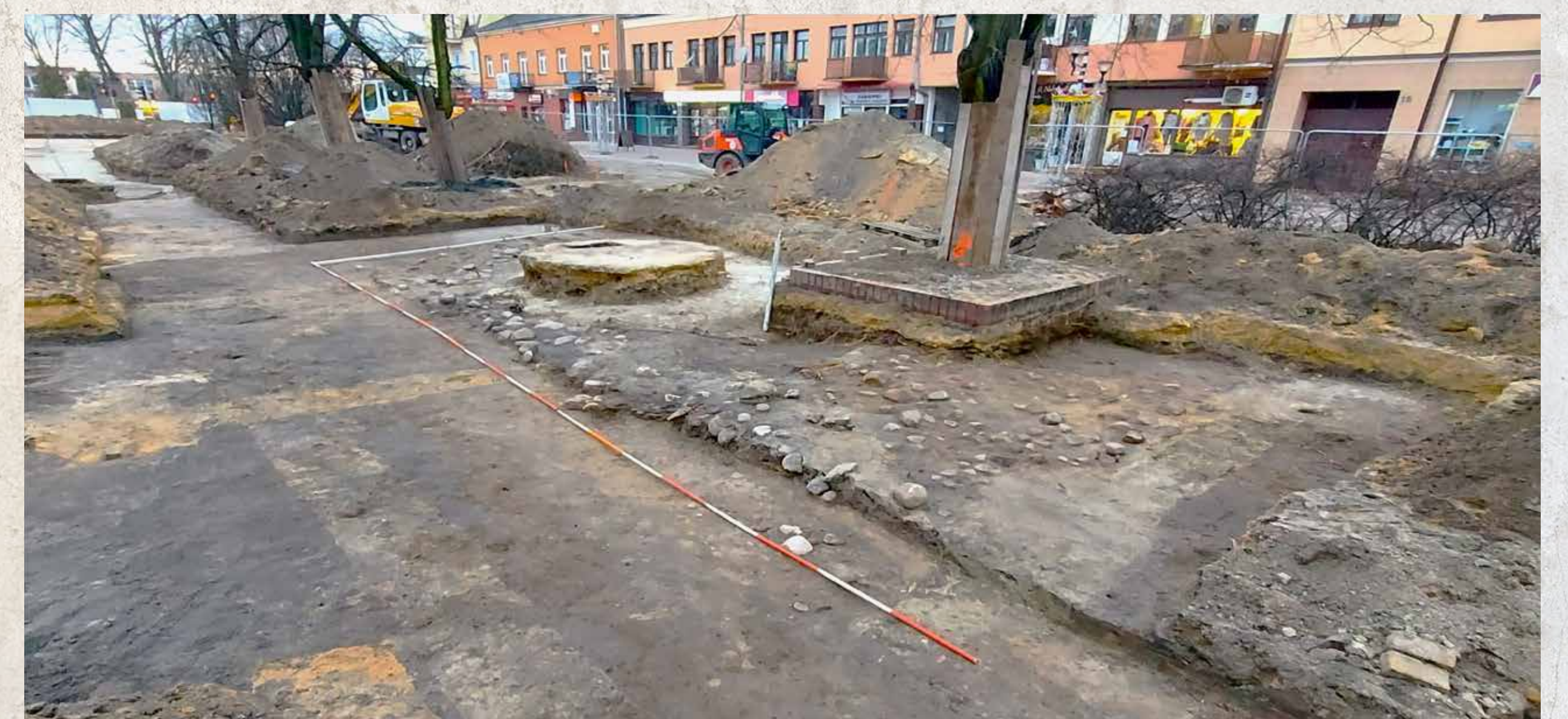
Fot. 5. Grodzisk Mazowiecki, Plac Wolności. Bruk kamienny silnie zniszczony przez liczne współczesne wkopy. Widok od strony południowo-wschodniej.
