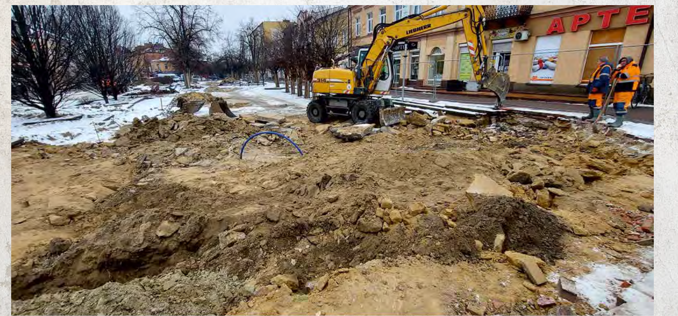
Fot. 3. Grodzisk Mazowiecki, usuwanie płyt betonowych z niecki deptaka do poziomu spągu starej podbudowy. Widok od strony północnej.
