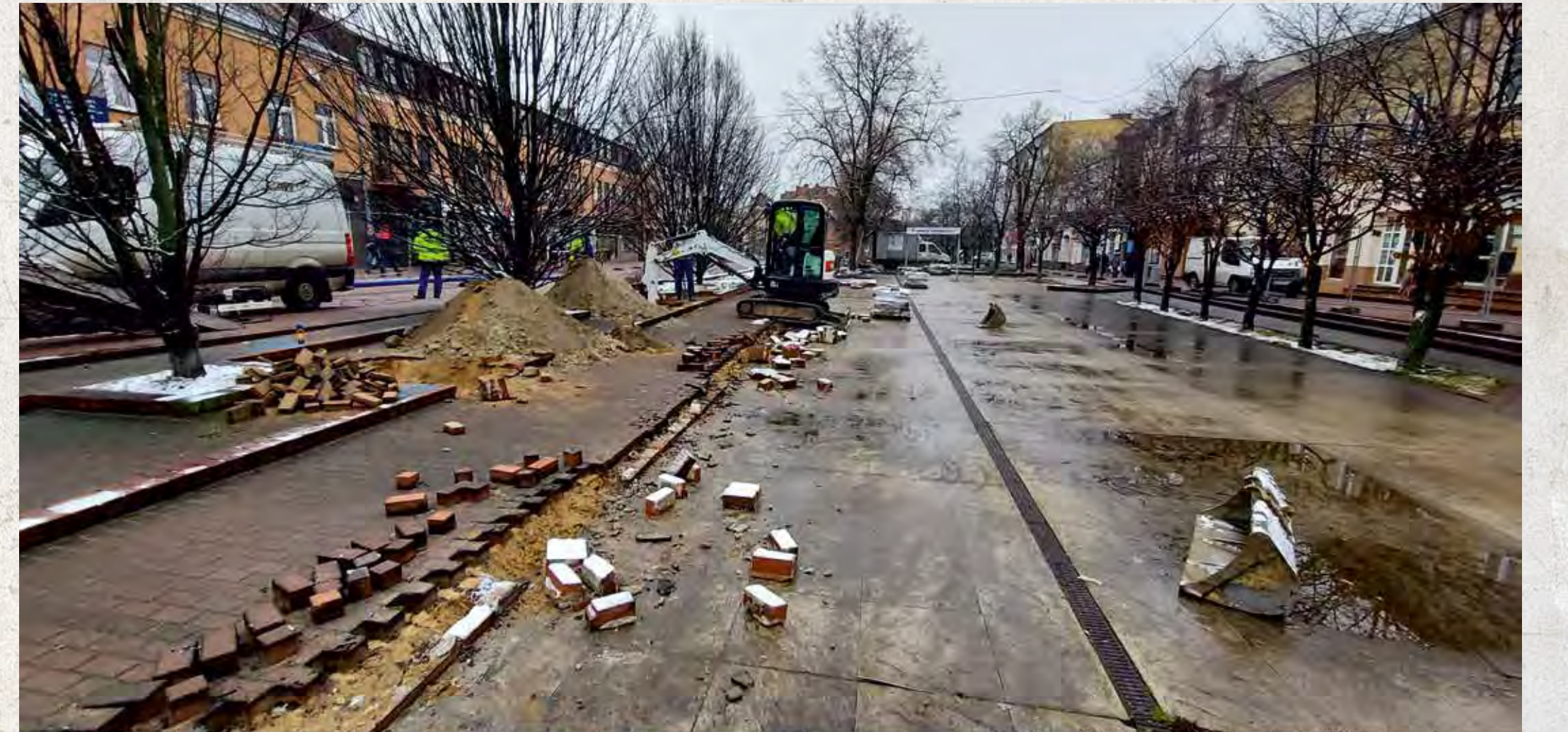
Fot. 2. Grodzisk Mazowiecki, rozpoczęcie prac budowlanych związanych z rewitalizacją Placu Wolności. Widok od strony południowej.
