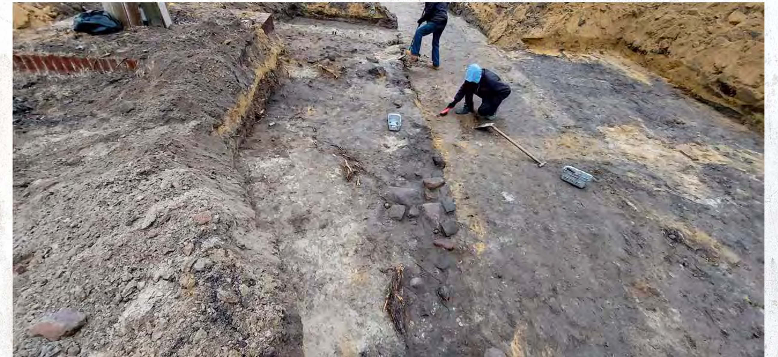
Fot. 3. Grodzisk Mazowiecki, Plac Wolności. Poszerzenie wykopu w celu uchwycenia całkowitego zasięgu bruku kamiennego. Widok od strony południowej.
