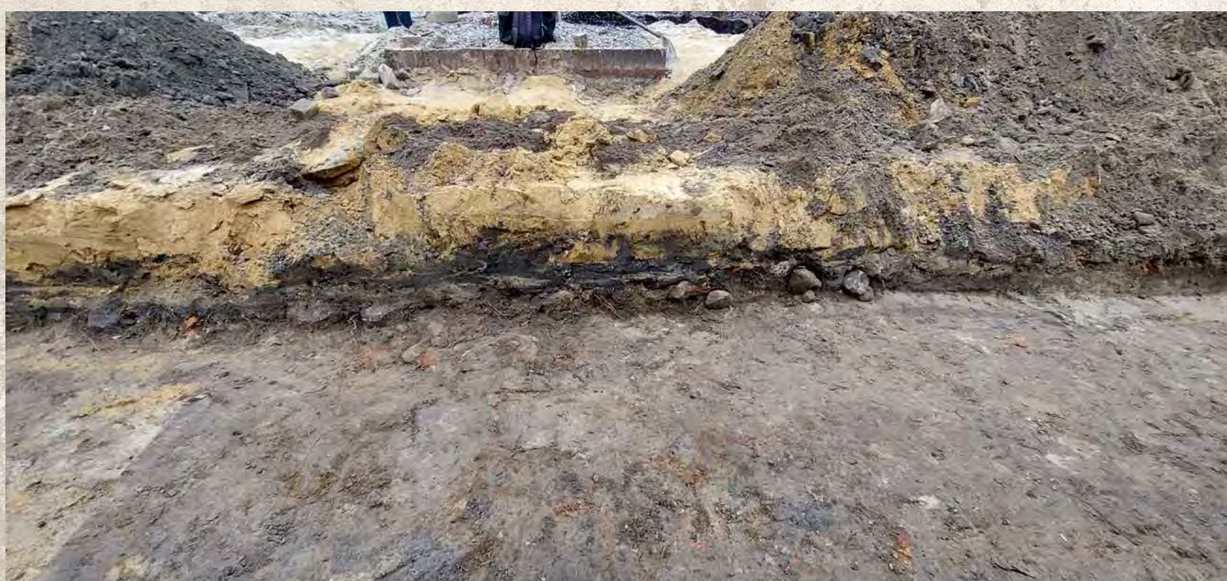
Fot. 2. Grodzisk Mazowiecki, Plac Wolności. Wykop pod kanalizację deszczową. Bruk kamienny widoczny w profilu. Widok od strony wschodniej.
