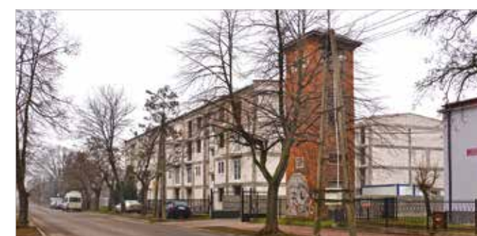
Nowe bloki mieszkaniowe przy ul. Traugutta
