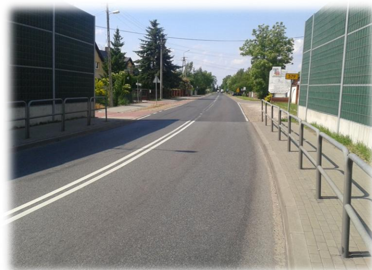
Foto.65/166 DW 579 – w kierunku północnym
