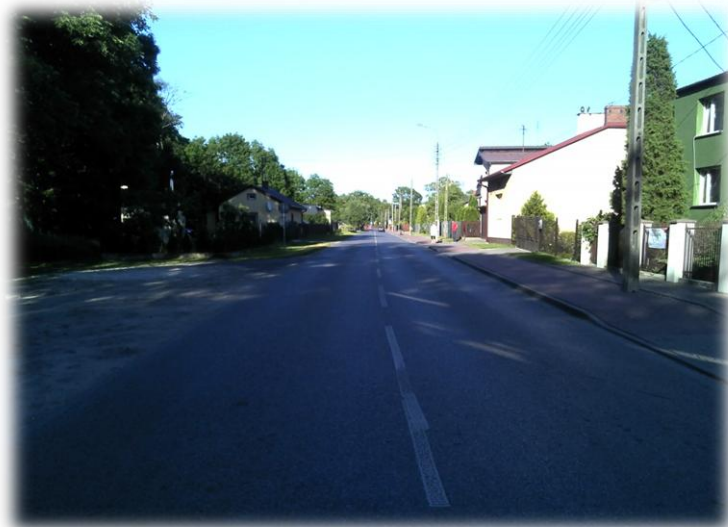
Foto.28/18 DP 1507 m. Izdebno Kościelne – w kierunku wschodnim
