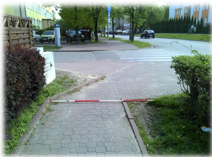
Foto.130/205 ul. Zondka – w kierunku wschodnim
