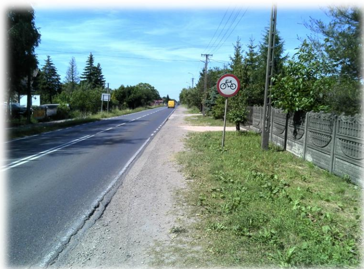
Foto.87/49 DW 579 – w kierunku północnym
