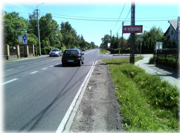
Foto.80/42 DW 579 – w kierunku północnym
