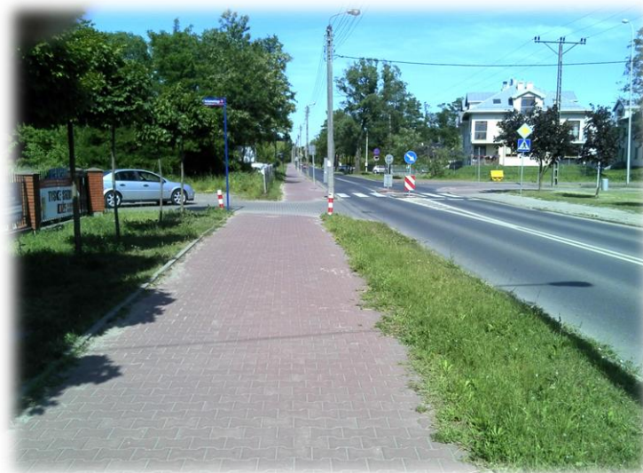
Foto.139/69 ul. 3 Maja (DP 1526) – w kierunku wschodnim
