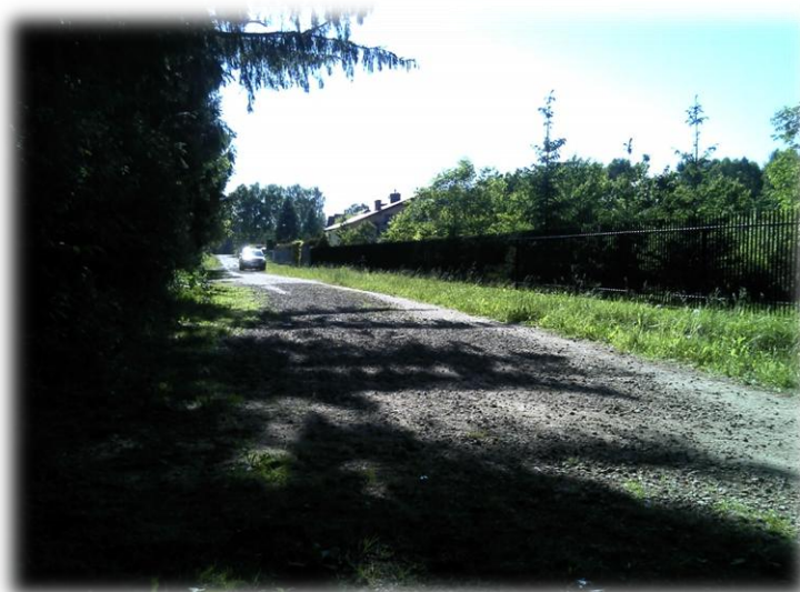
Foto.59/105 ul. Przesmyk – w kierunku zachodnim
