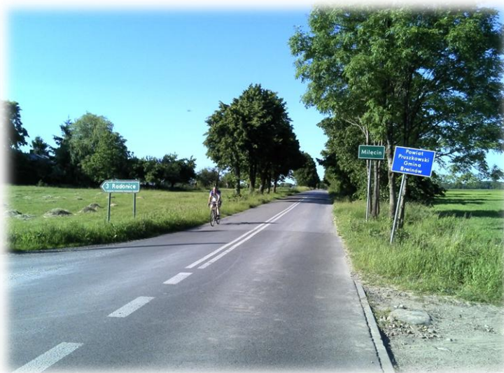
Foto.17/1 DP 1509 styk z Gminą Brwinów – w kierunku północnym
