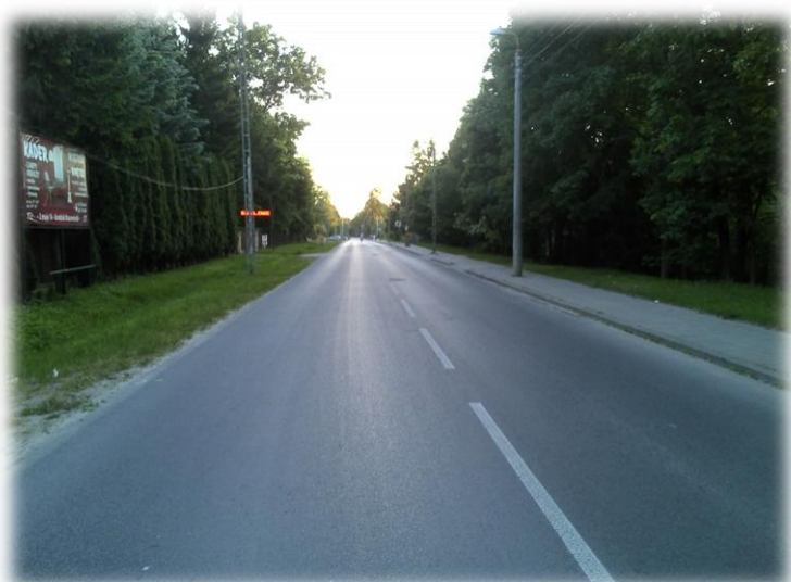
Foto.142/39 ul. 3 Maja (DP 1526) – w kierunku zachodnim
