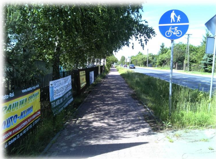
Foto.85/43 DW 579 – w kierunku północnym
