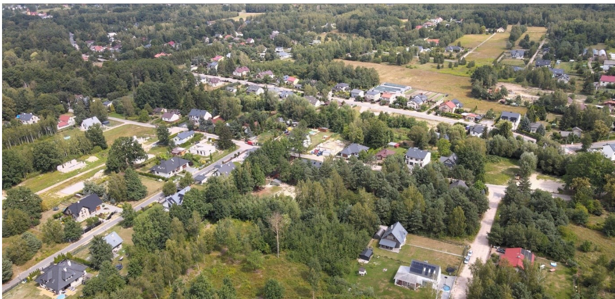
Fotografia 2. Widok na zabudowę jednorodzinną rozwijającą się pomiędzy terenami leśnymi i zadrzewionymi na południu gminy
